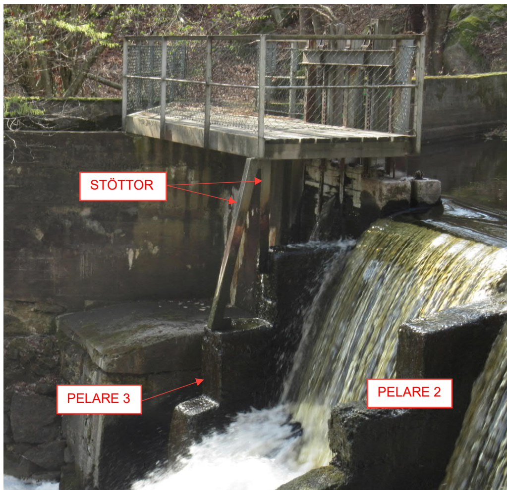
Figur 4. Stålstöttor på pelare 3 för bro.
