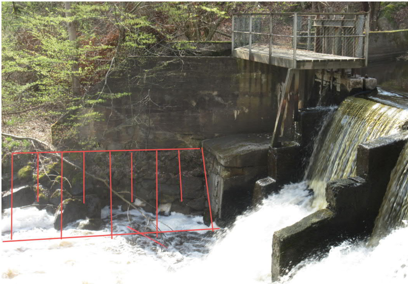
Figur 5. Yta för stabiliserande åtgärd.
