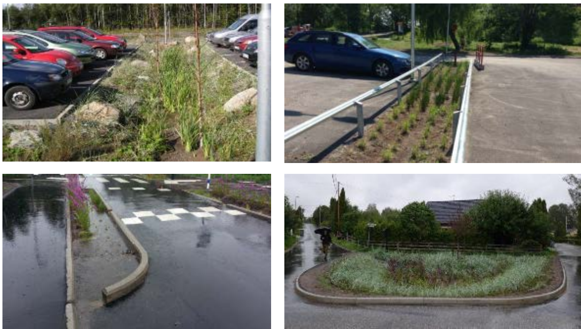
Figur 6: Uppe t v: Raingarden vid pendlarparkeringen Campus Roslagen i Norrtälje, källa: Veg Tech AB. Uppe t h: Raingarden i Portland USA. Nere t v: Raingarden vid Öringevägen i Tyresö kommun, källa: WSP. Nere t h: Raingarden vid Åkervägen Tyresö. Källa WSP.
