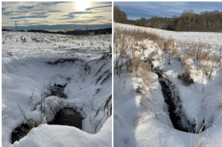
Figur 11 Bilder på dräneringsledningen från Ronneby kommunen platsbesök 9 januari 2024 (Foto: Ronneby kommun)
