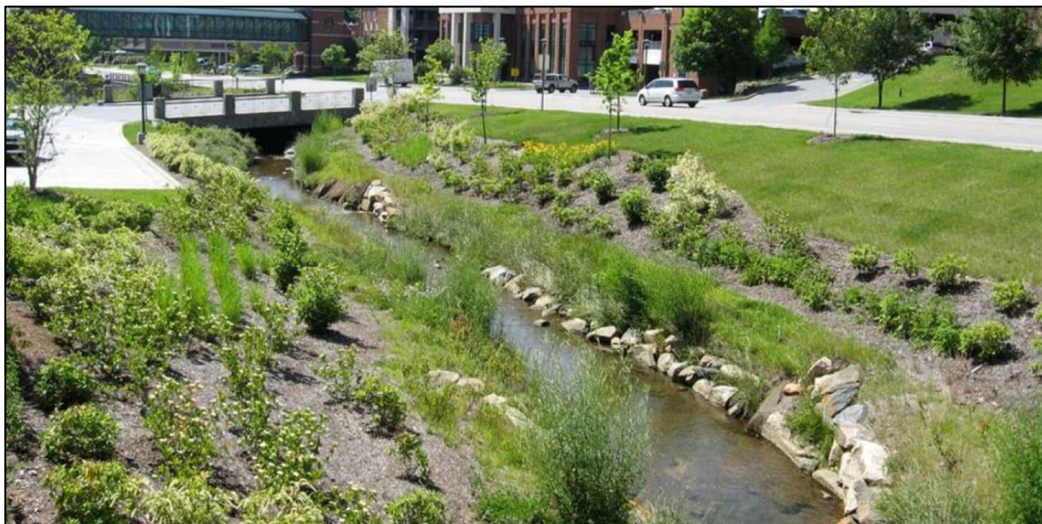
Figur 19. Exempel på ett vattenförande svackdike (Boone creek) men vegetation i slänterna (Foto: Appalachian State).
