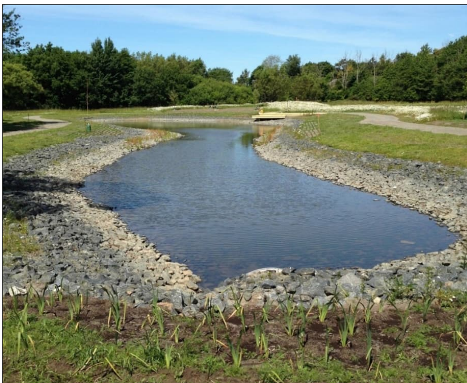
Figur 17. Exempel på dagvattendamm i Trönninge i Varberg (Foto: Norconsult).
