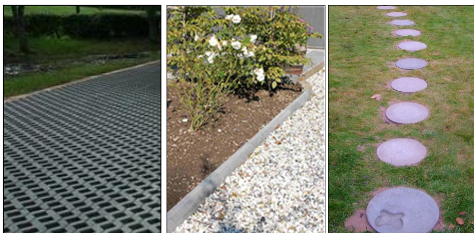
Figur 23. Yta med hålsten av betong, makadambelagd gång, samt gångstig med gräs och några gångplattor i betong (Foto: Norconsult)
